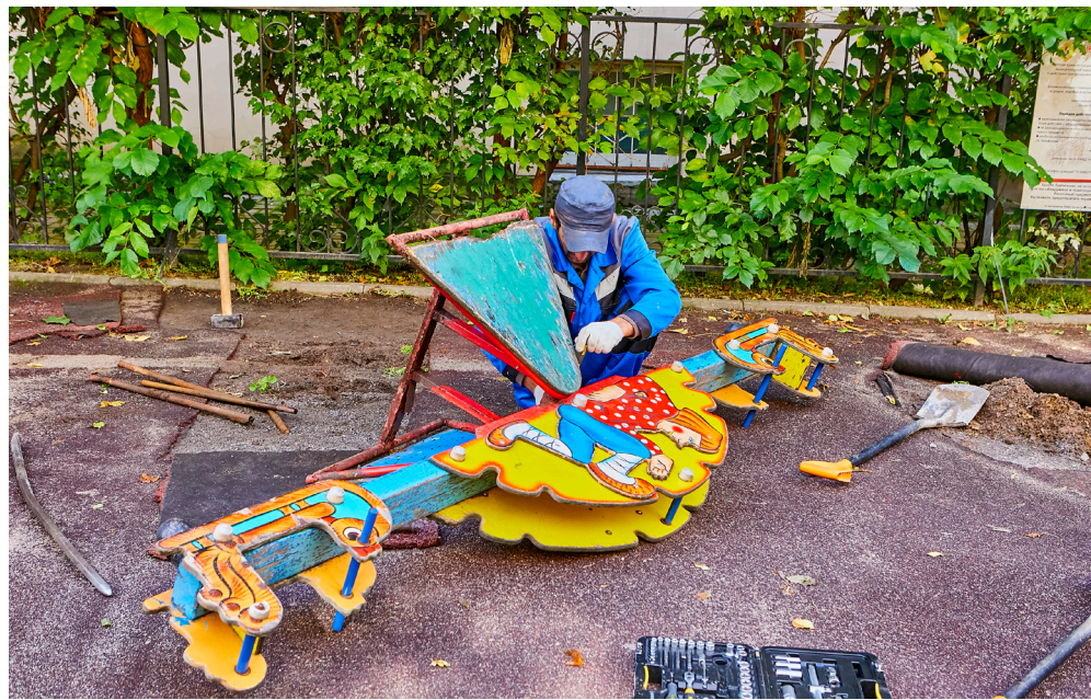
Демонтаж детской площадки во дворе по адресу: Большая Конюшенная улица, д. 5
